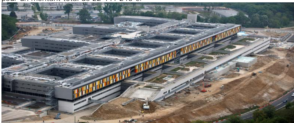
Chantier du nouvel hôpital Sud-Francilien – photo crédit : Laurent DELAGE
