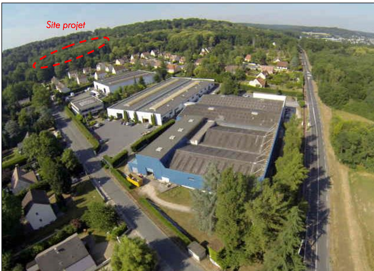
Zone d'activités de Beaurepaire vue en direction du sud-ouest : à droite le chemin de Beaurepaire (vers Dourdan), à gauche l'allée du 6 juin 1944, au premier plan l'entreprise ORAY et au second plan LSF et les Cartonages du Val d'Orge (photographie : ORAY).
