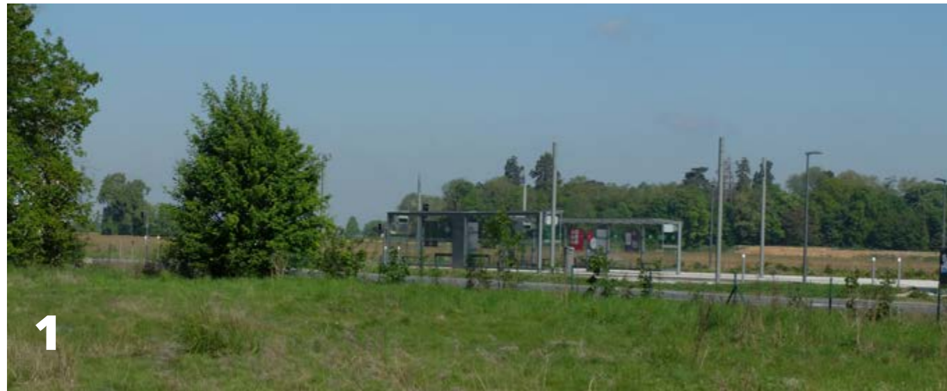
1 Vue de l'arrêt du TCSP sur la RD128 (source TRANS-FAIRE, 2017)
