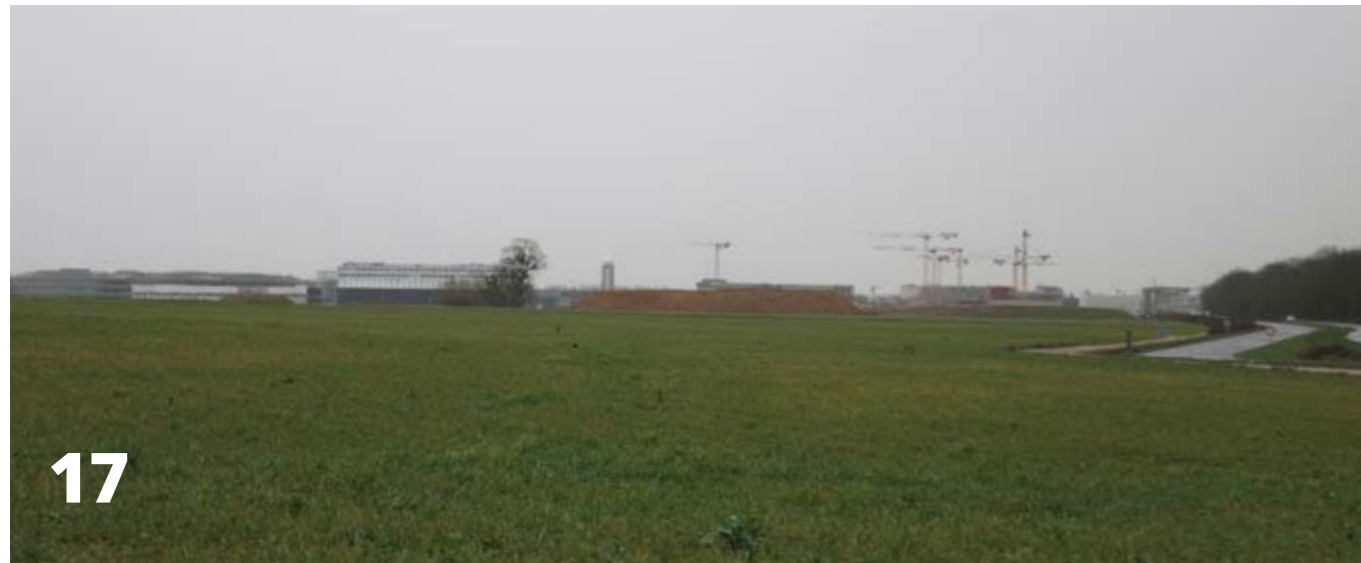
La friche industrielle de Thalès (source TRANS-FAIRE, 2017)
