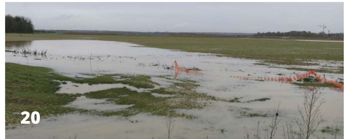
Les travaux pour la création du corridor écologique (source TRANS-FAIRE, 2018)
