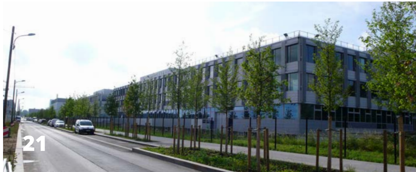
Vue du bâtiment de Nano-INNOV (source TRANS-FAIRE, 2018)
