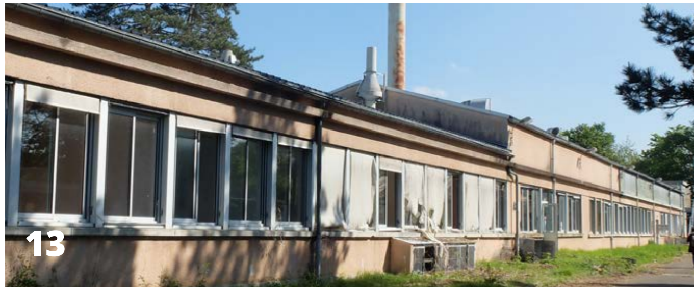
La friche industrielle de Thalès (source TRANS-FAIRE, 2017)
