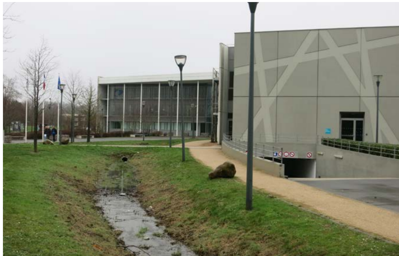
Ouvrages de rétention de l'ENSTA (source TRANS-FAIRE, 2018)
