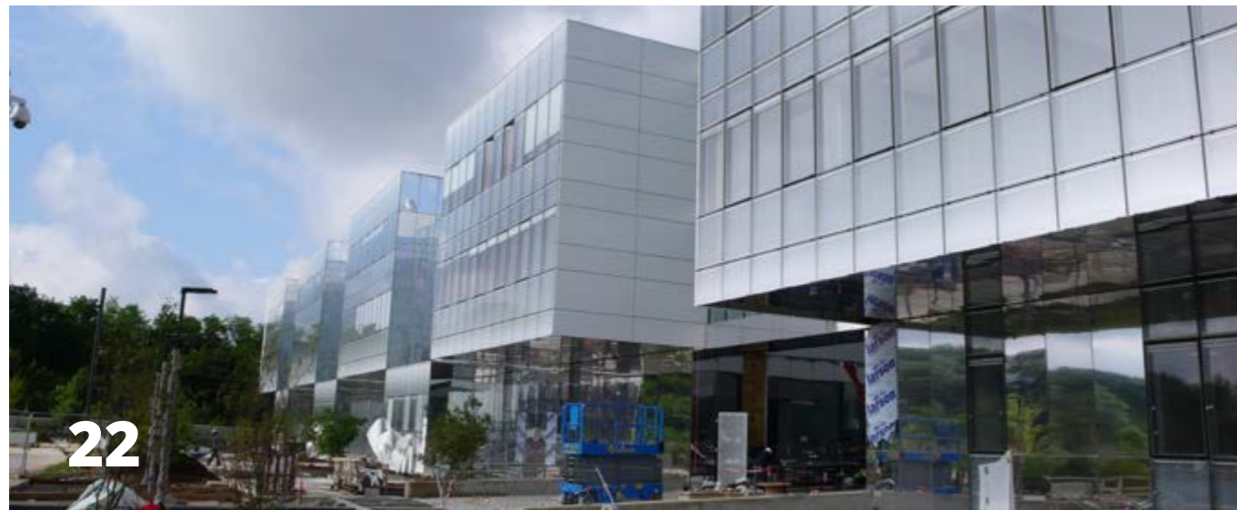
Vue du C2N en cours de livraison (source TRANS-FAIRE, 2018)
