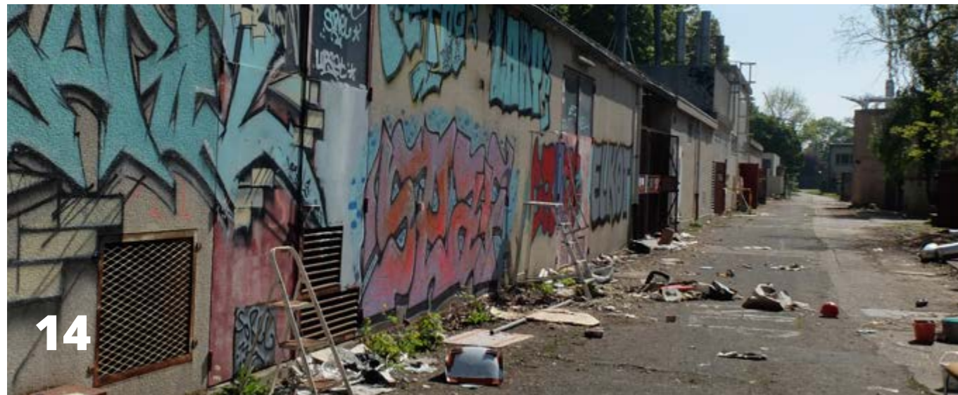
La friche industrielle de Thalès (source TRANS-FAIRE, 2017)
