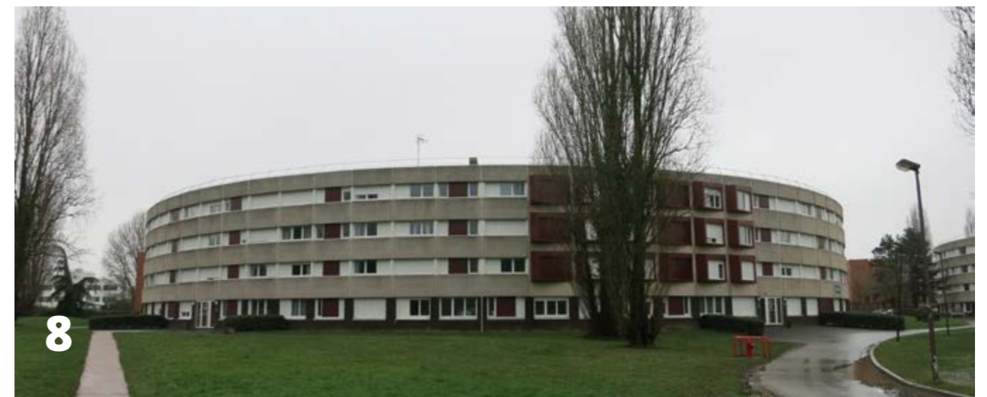
Vue du bâtiment Fayolle (source TRANS-FAIRE, 2018)
