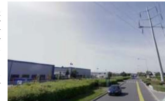
Photographie 6 : La ligne HT
