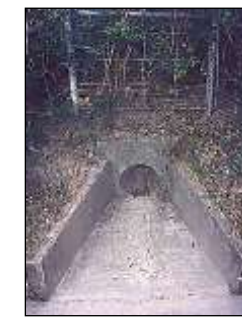
Buse avec entonnement pour faciliter l'entrée des petits mammifères (source : J. Carsignol, CETE de l'Est)
