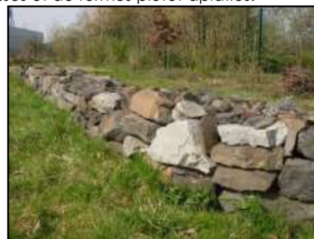
Muret de pierres sèches
