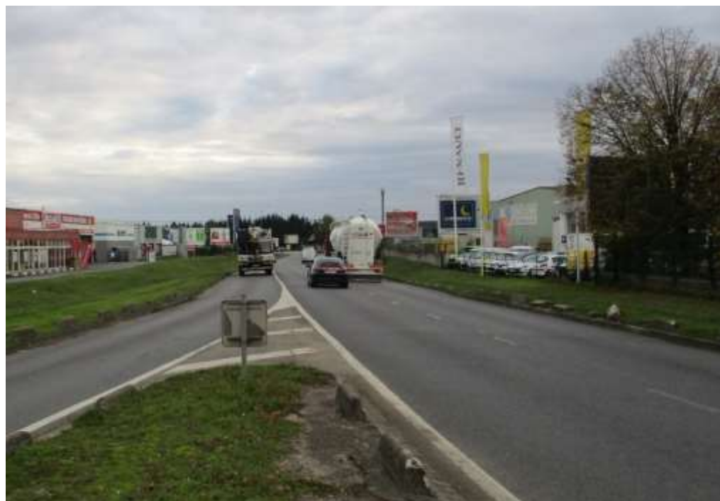
Photographie 13 : Des infrastructures à grand trafic : véritables coupures
